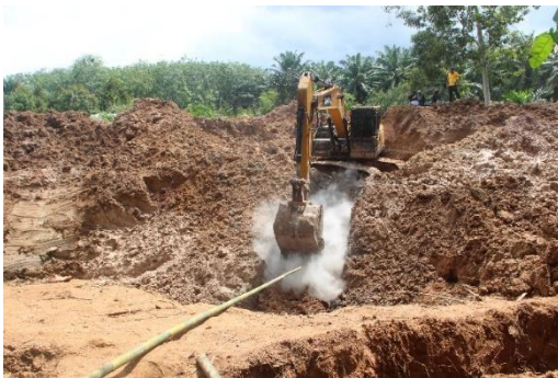
ภาพที่ 4.19 ก่อสร้างฝายชะลอน้ำ จ.พะเยา แห่งที่ ๒ ขนาดฝายชะลอน้ำ กว้าง ๘ เมตร
