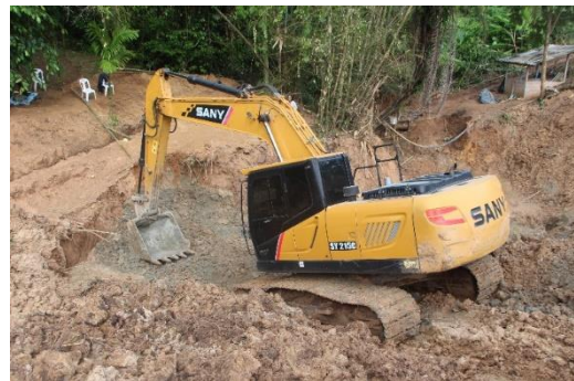
ภาพที่ 4.19 ก่อสร้างฝายชะลอน้ำ จ.พะเยา แห่งที่ ๒ ขนาดฝายชะลอน้ำ กว้าง ๘ เมตร
