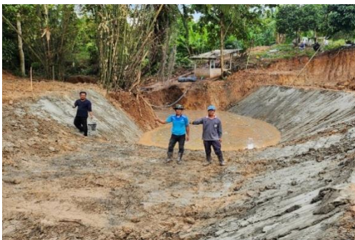
ภาพที่ 4.20 ก่อสร้างฝายชะลอน้ำ จ.ชุมพร แห่งที่ ๑ ขนาดฝายชะลอน้ำ กว้าง ๗ เมตร
