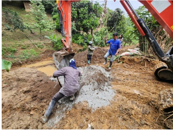
ภาพที่ 4.15 การผสมดินกับปูนซีเมนต์ตามอัตราส่วนที่กำหนด
