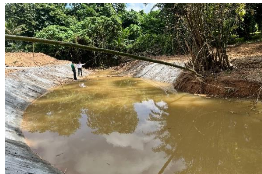
ภาพที่ 4.20 ก่อสร้างฝายชะลอน้ำ จ.ชุมพร แห่งที่ ๑ ขนาดฝายชะลอน้ำ กว้าง ๗ เมตร
