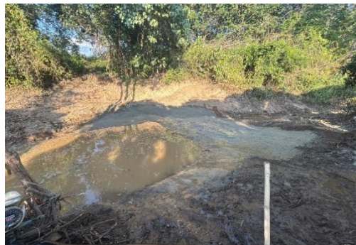
ภาพที่ 4.19 ก่อสร้างฝายชะลอน้ำ จ.พะเยา แห่งที่ ๒ ขนาดฝายชะลอน้ำ กว้าง ๘ เมตร
