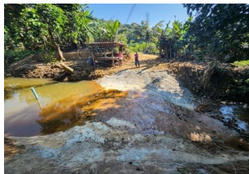
ภาพที่ 4.18 ก่อสร้างฝายชะลอน้ำ จ.พะเยา แห่งที่ 1 ขนาดฝายชะลอน้ำ กว้าง 8 เมตร
