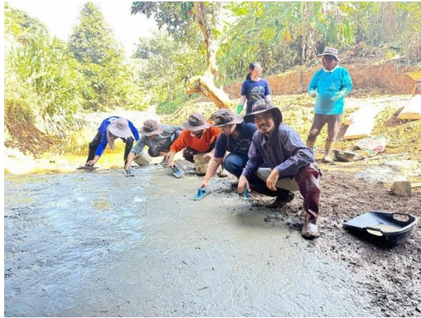
ภาพที่ 4.17 ขั้นตอนการปรับแต่งฝายชะลอน้ำแบบชั่วคราวชนิดดินซีเมนต์
