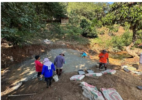
ภาพที่ 4.18 ก่อสร้างฝายชะลอน้ำ จ.พะเยา แห่งที่ 1 ขนาดฝายชะลอน้ำ กว้าง 8 เมตร
