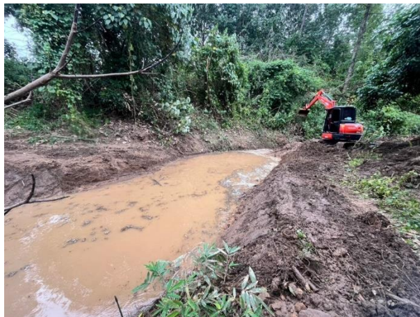
ภาพที่ 4.12 กำจัดวัชพืชลำน้ำ และปรับแต่งสภาพลำน้ำ
