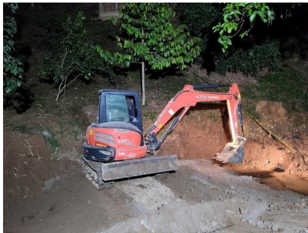
ภาพที่ 4.16 การบดอัดดินซีเมนต์ตัวฝาย
