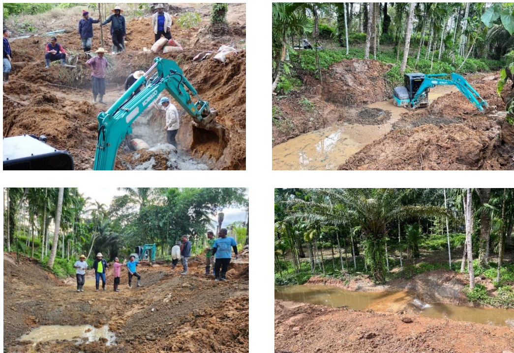
ภาพที่ 4.21 ก่อสร้างฝายชะลอน้ำ จ.ชุมพร แห่งที่ 2 ขนาดฝายชะลอน้ำ กว้าง 7 เมตร
